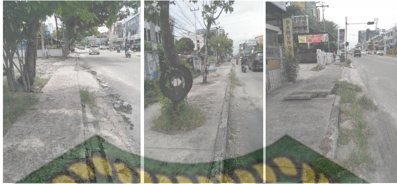
Gambar 5.1 Kondisi Eksisting Lebar Jalur Pedestrian di Jalan Riau,
